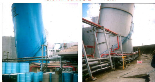
液状化によるタンクの傾斜・沈下・移動 (1995年兵庫県南部地震、神戸市長田区)
